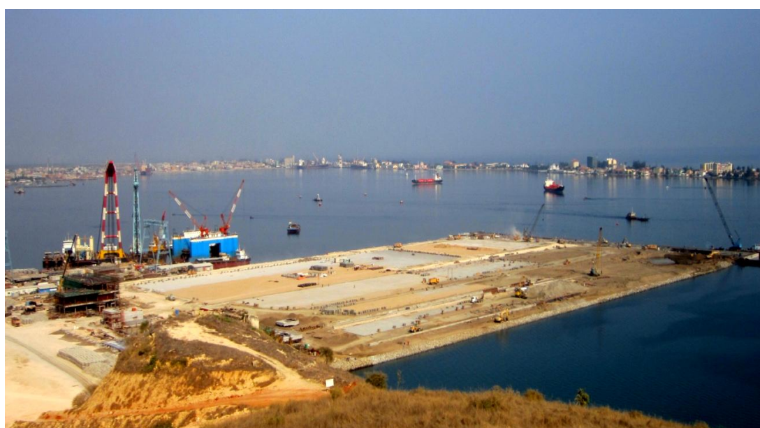
俯瞰洛比托港扩建项目——矿石码头
