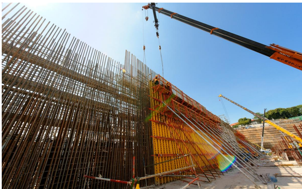
地下室挡土墙模版安装
