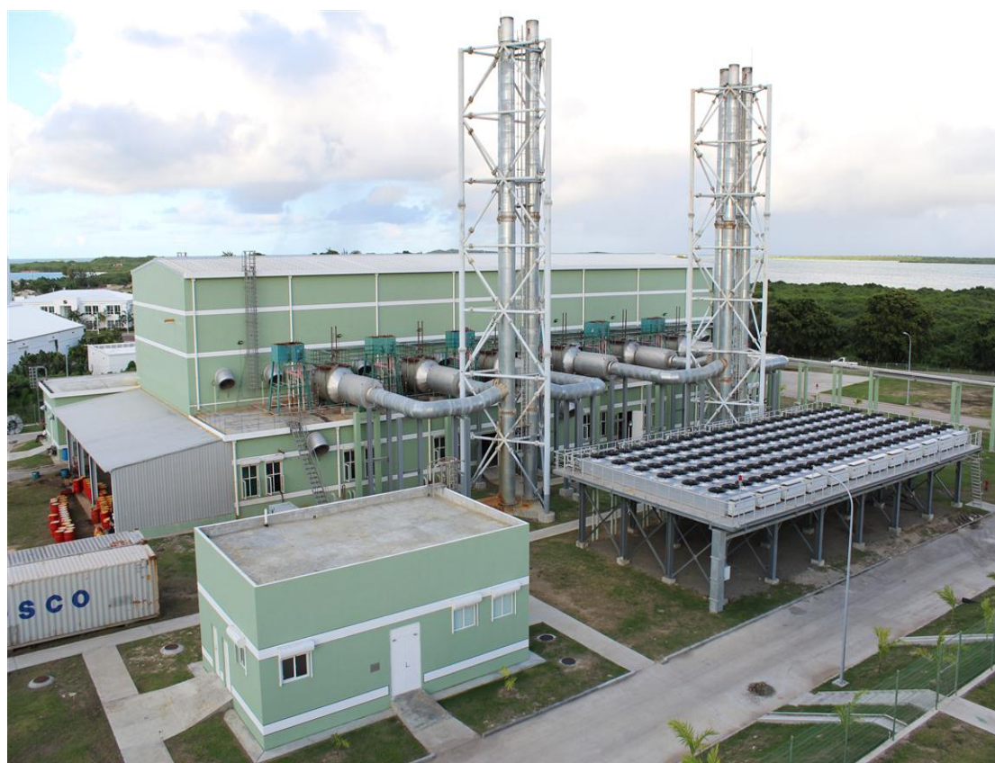
电厂外观现状图
