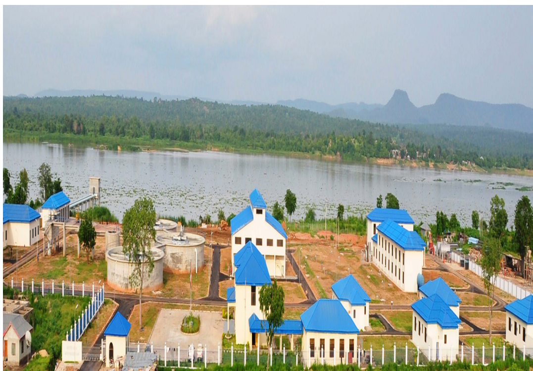
洛科贾 LOKOJA 水厂建成后水厂场区
