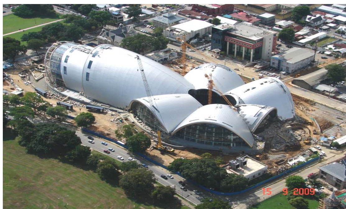
特多大文化中心施工现场
