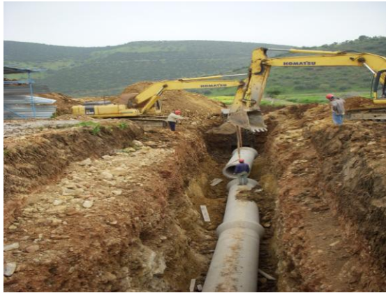
Tiaret 混凝土管道安装
