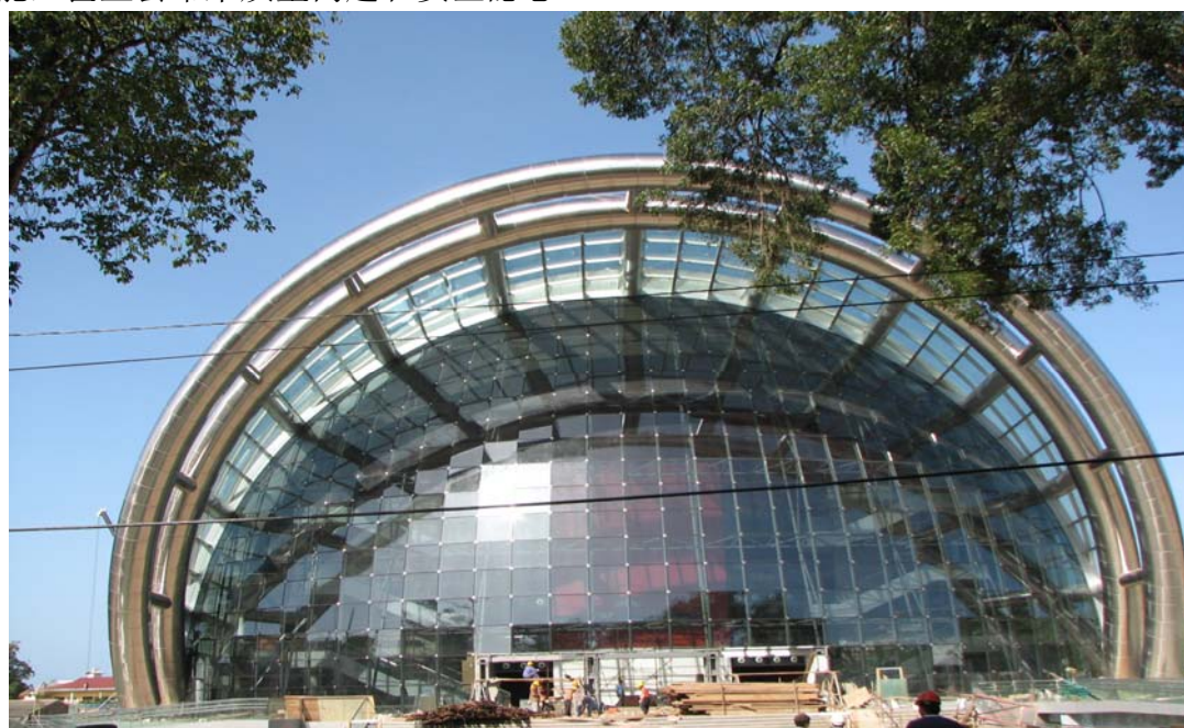
特多大文化中心施工现场
