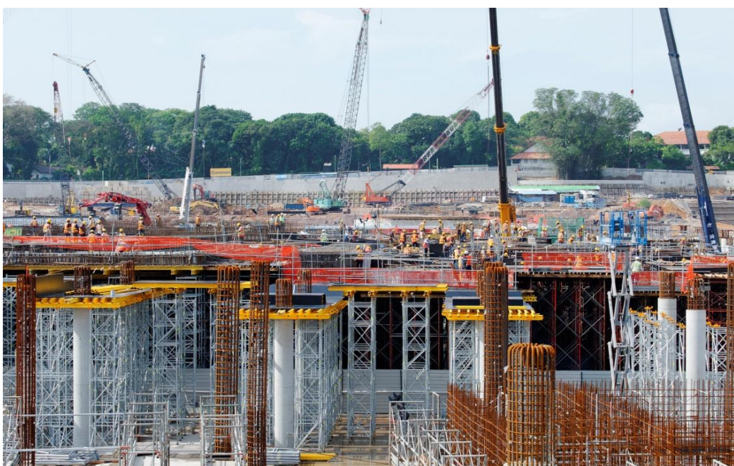
地下室顶板施工
