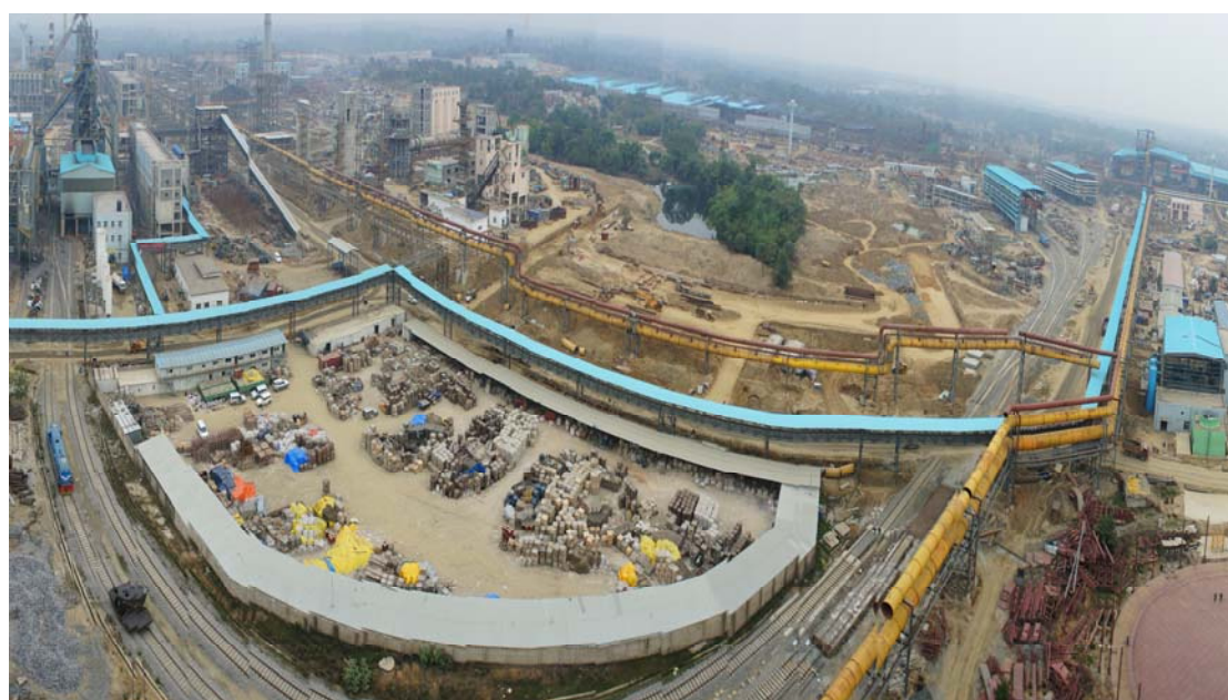
印度电钢项目施工全景
