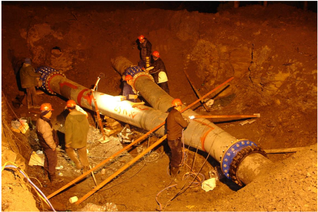
Constantine 管网维修项目—夜晚维修
