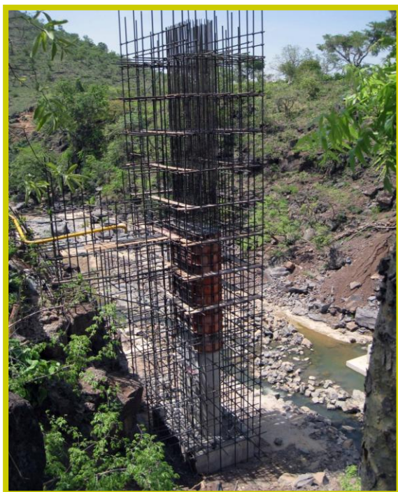
图为 Jibam 大桥浇筑混凝土
