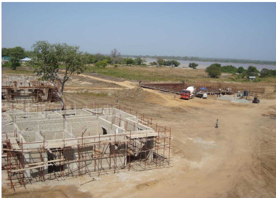
洛科贾 LOKOJA 水厂项目开工现场
