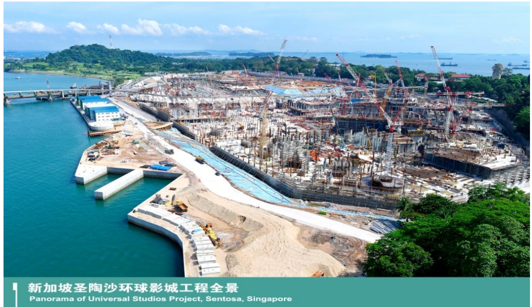
新加坡环球影城项目工程全景
