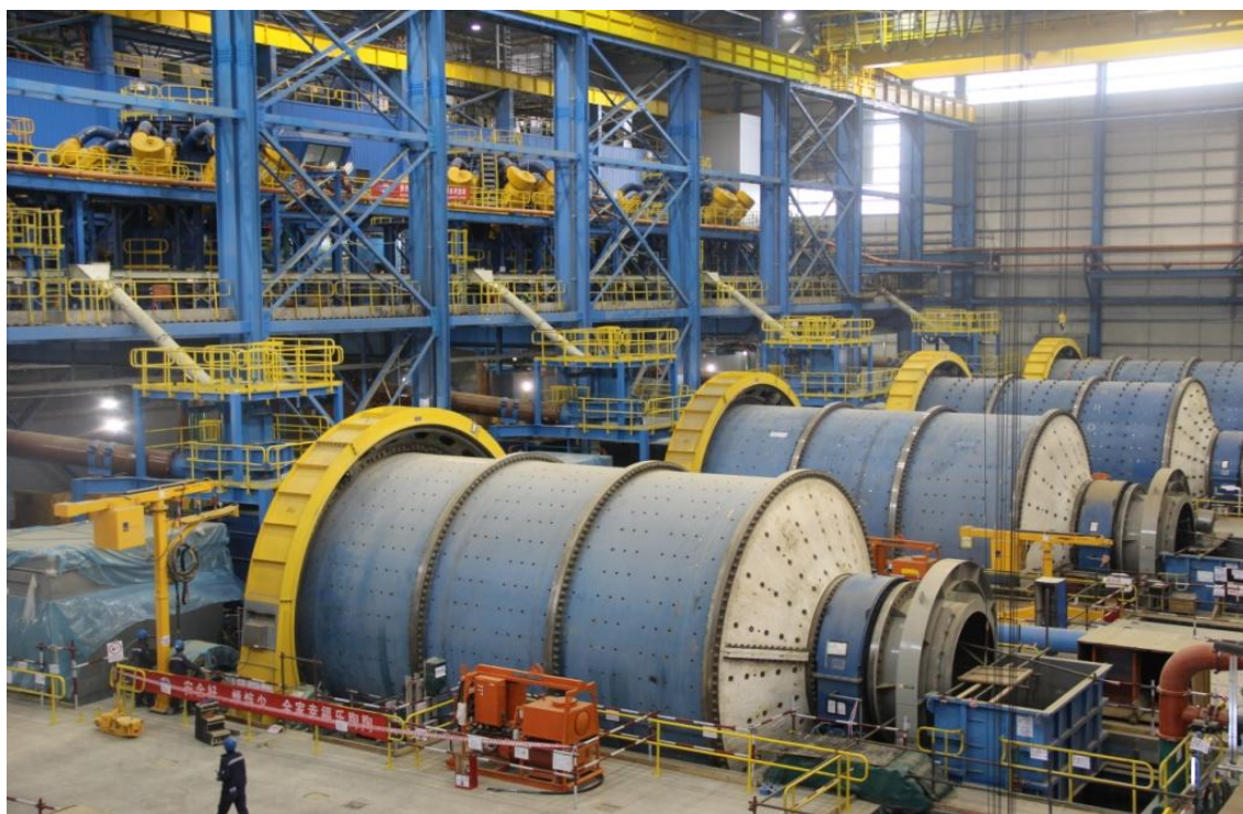
蒙古奥尤陶勒盖项目选矿厂四台球磨机正在安装调试
