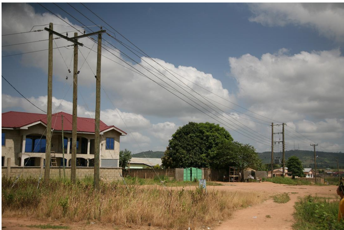
施工验收后的农村线路
