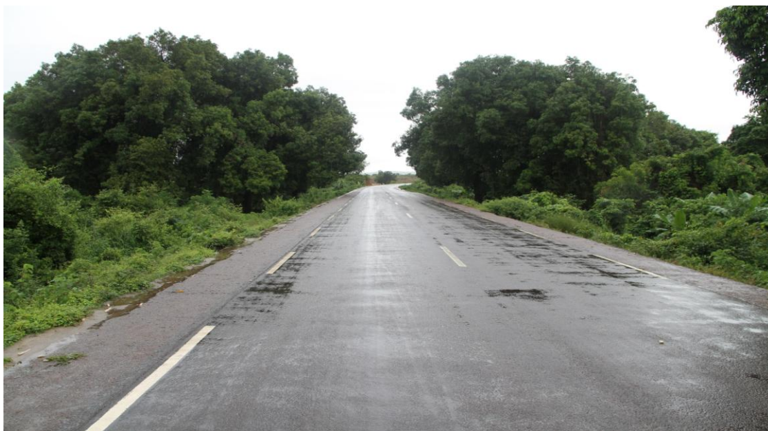
施工完的路面工程
