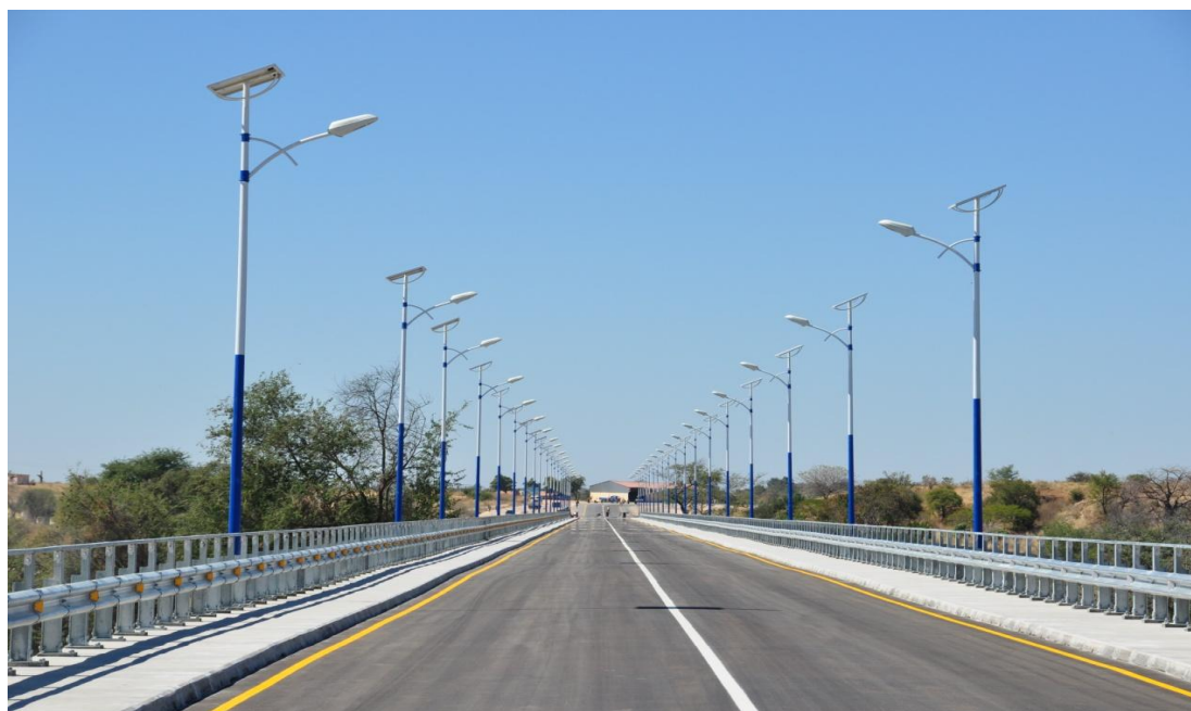
安哥拉 Xangango 大桥项目竣工全景图
