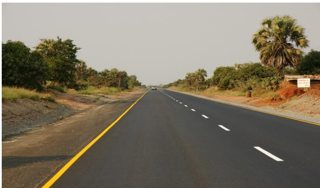
Kifangondo-Negage 项目竣工全景图
