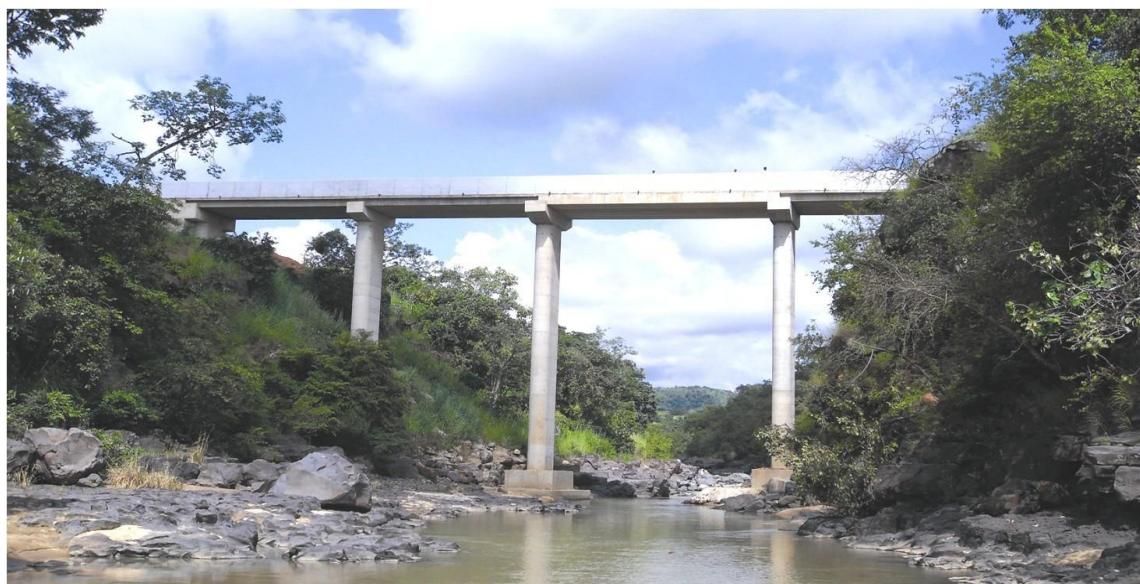
竣工后的 Jibam 大桥
