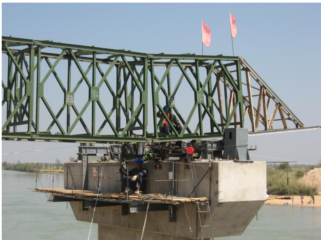
安哥拉 Xangango 大桥项目顶推控制
