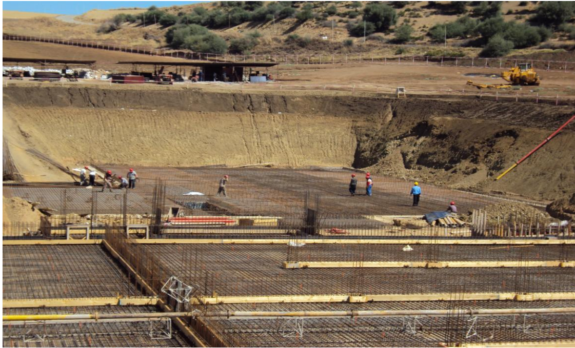
正在施工的水厂清水池
