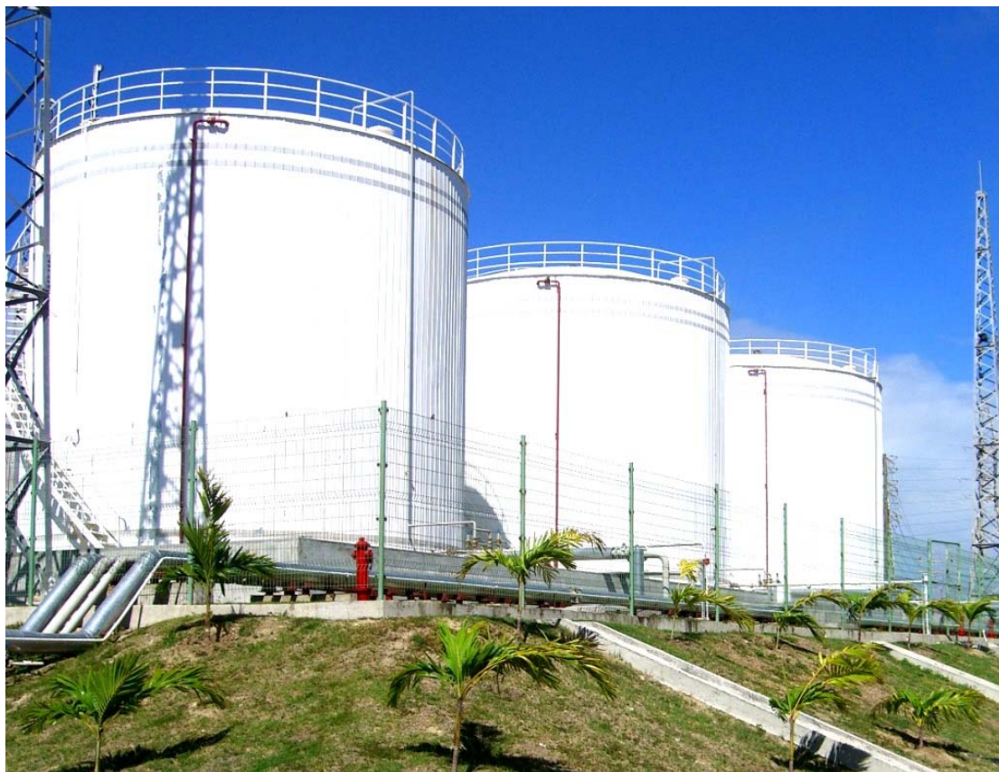
油罐区局部现状
