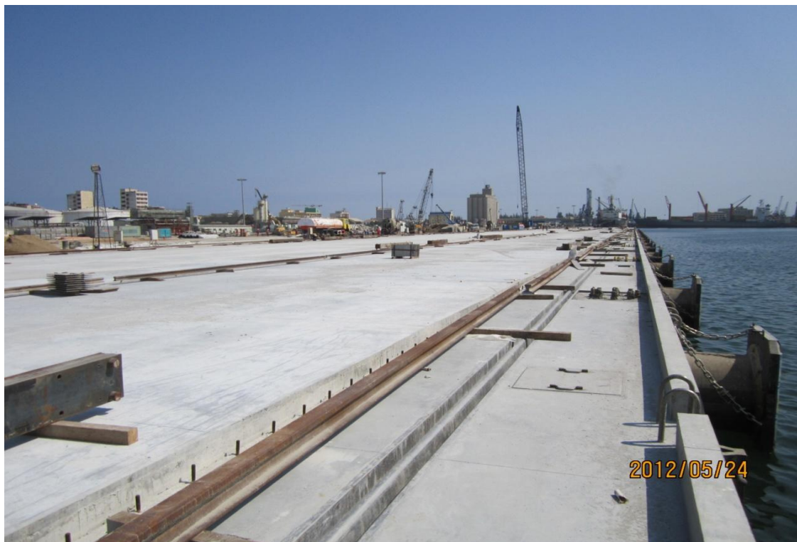
洛比托港扩建项目——集装箱码头
