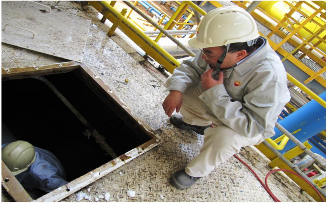
空分装置冷箱裸冷、查漏，张军亲自督战
