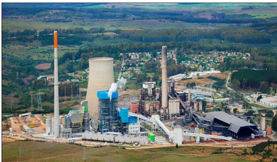
鸟瞰建成发电后的巴西坎迪奥塔火电厂二期C项目电厂
