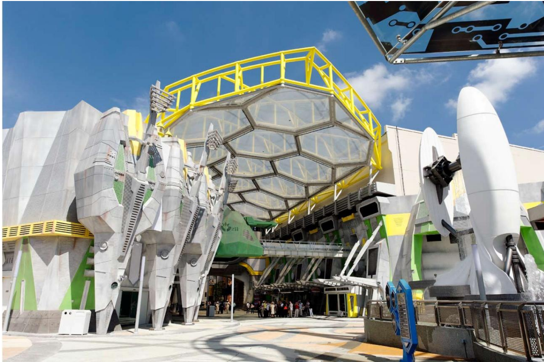
科幻城 FAÇADE 安装外观
