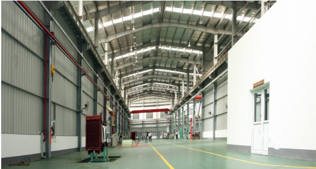
缅甸多功能柴油机厂总装车间-内部
