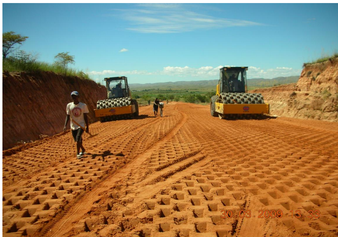
路基施工现场
