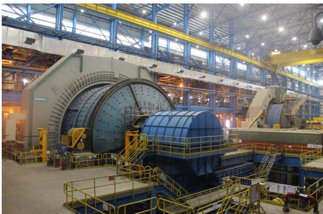
蒙古奥尤陶勒盖项目选矿厂两台半自磨机正在紧张施工中
