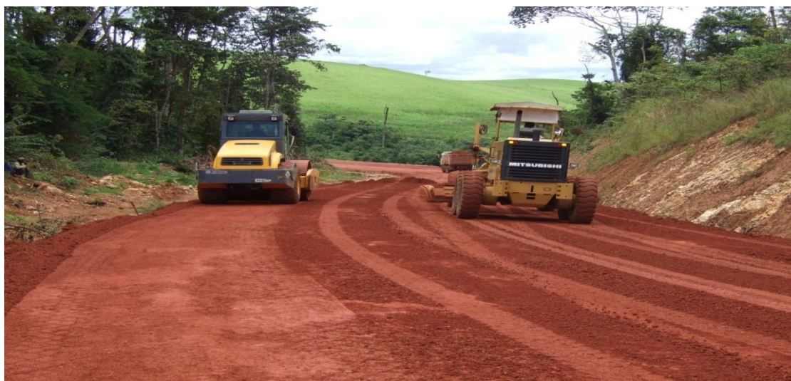
Kifangondo-Negage 项目底基层施工过程中
