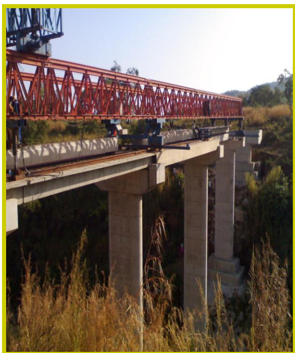
图为 Jibam 大桥架梁
