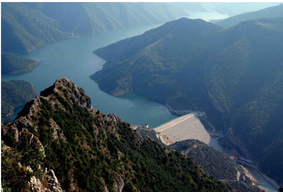
马其顿水电站水库大坝全景
