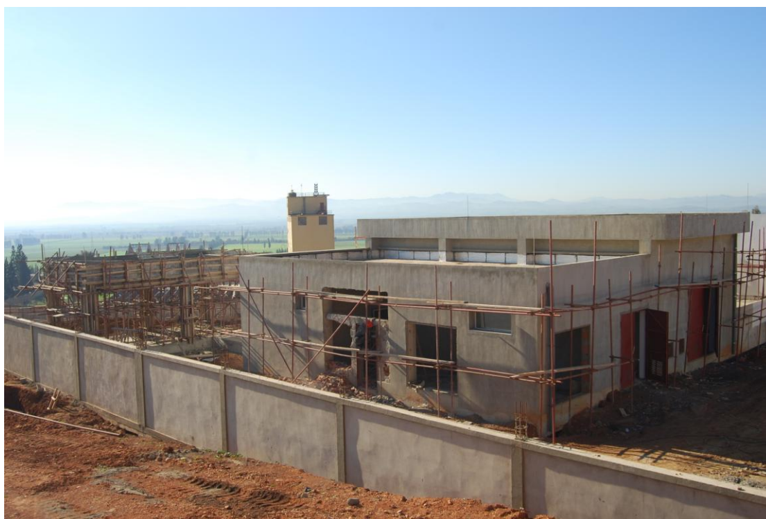
正在施工的加压泵站
