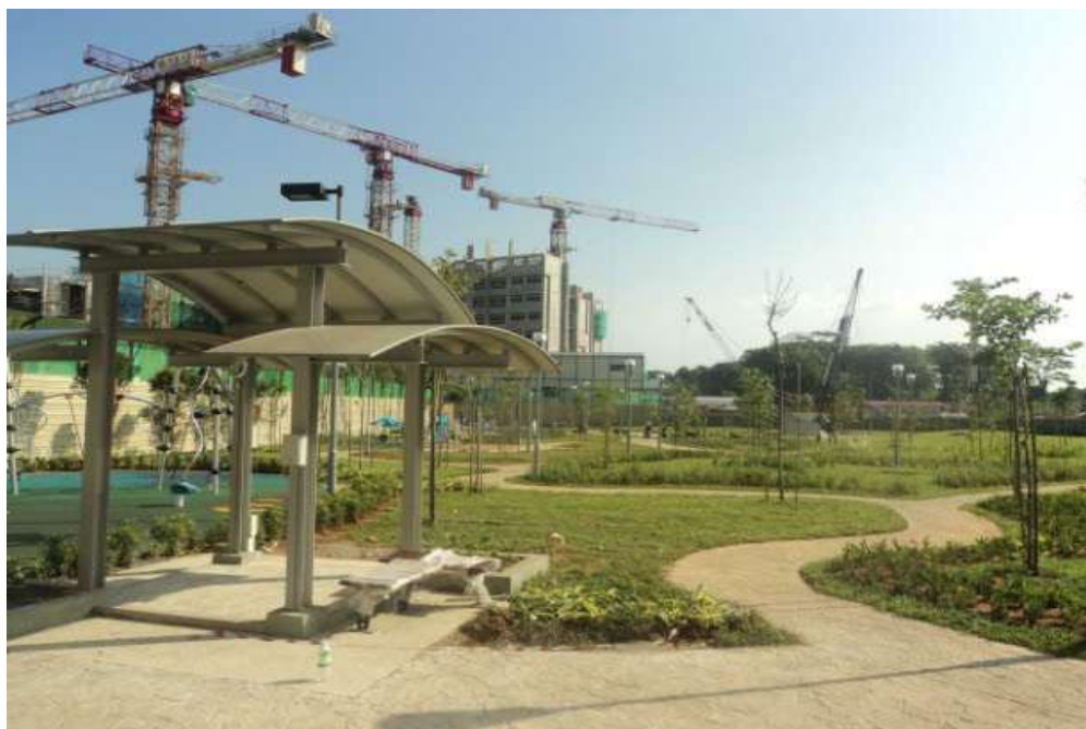
新加坡盛港 678 套政府组屋项目施工现场
