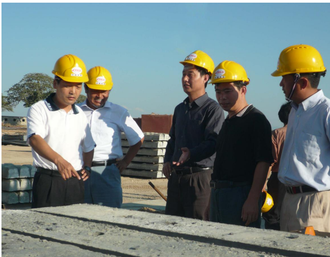
王选尚（左一）检查施工现场
