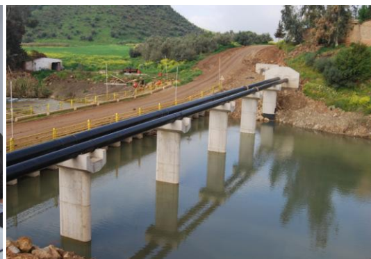
安装好的管桥
