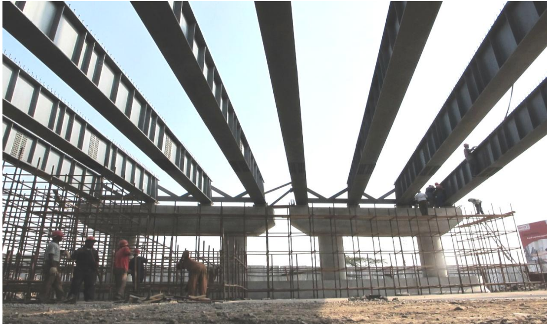
项目桥梁施工过程中
